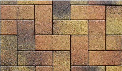
Фрагмент схемы укладки тротуарной плитки.
