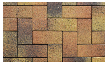
Фрагмент схемы укладки тротуарной плитки.
